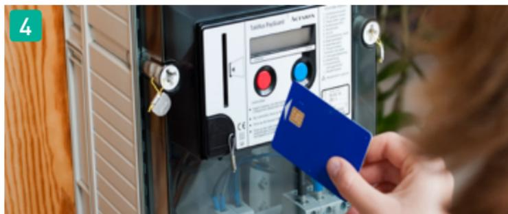
Il fonctionne par prépaiement via une carte électronique rechargeable. Il faut donc charger sa carte avant d'avoir du gaz ou de l'électricité.
