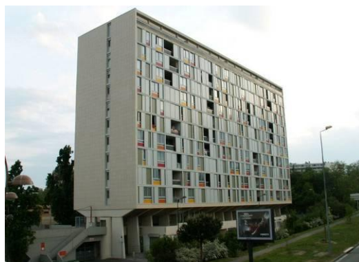
Immeuble du quartier Bellefontaine (Toulouse)
